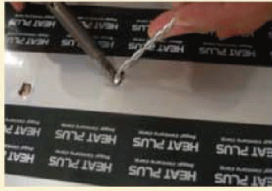
5. 剥き出した銅板部分に鉛付け
