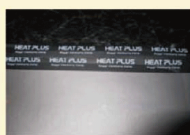
7. 鉛部分をBUTYLテープにて絶縁 (裏面も絶縁テープで処理)
