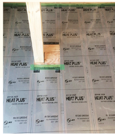
【柱部位処理 現場対応可能】
