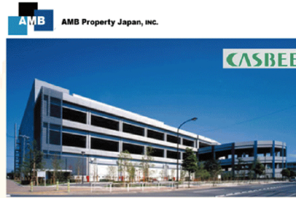
冷却倉庫の結露防止
